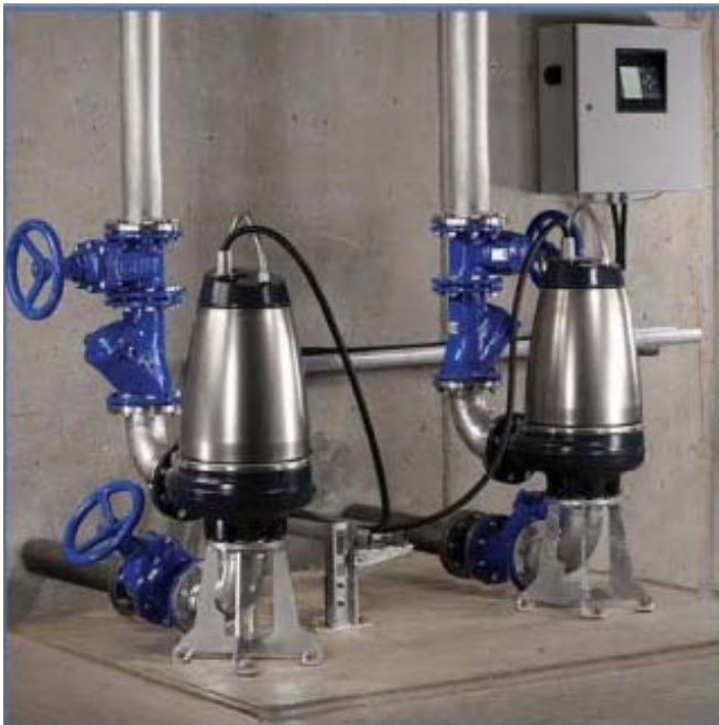
Instalación vertical en seco
