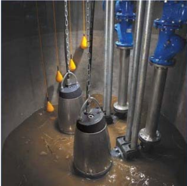
Instalación sumergida con auto acoplamiento con tubos guía.
